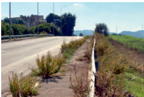
Fig. 1 Area limitrofa alla piscina (foto, 2024)
