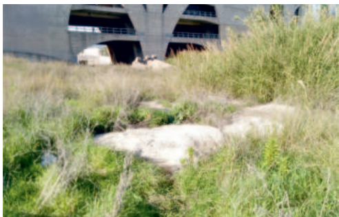
Fig. 44 Area di cantiere
