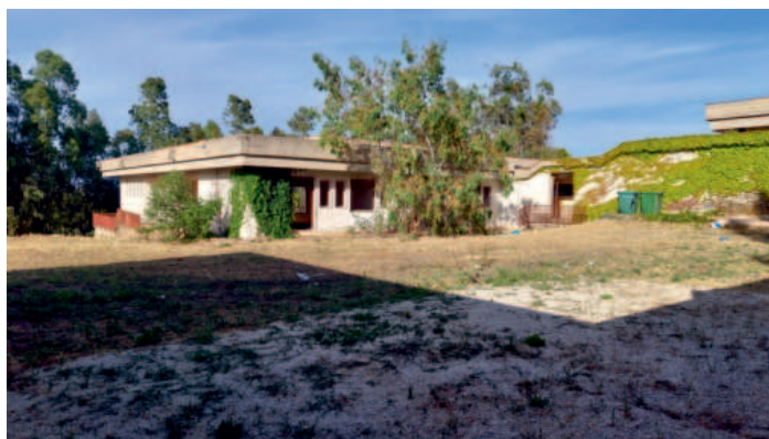
Fig. 25a Ala della Scuola San Francesco sottoposta a interventi di manutenzione straordinaria.
