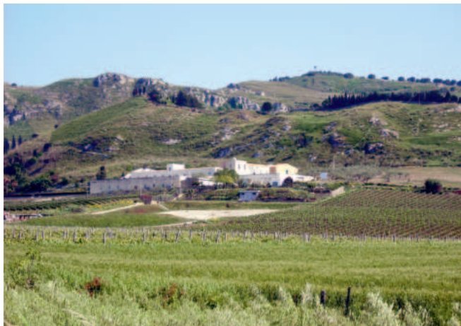
Fig. 30 Il Baglio Di Stefano, ristrutturato tra il 1982 e il 1999, conserva l'impianto tipico delle corti mediterranee. Oggi l'edificio ospita funzioni culturali e museali
