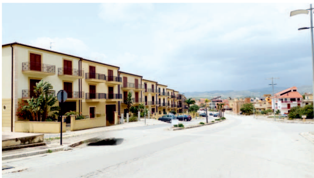
Fig. 39 Le abitazioni in viale De Roberto (foto, 2023)
