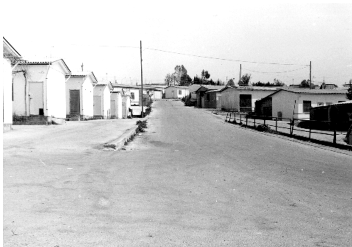
Fig. 10 Tratto della bretella che collega la statale 119 alla provinciale per Partanna
