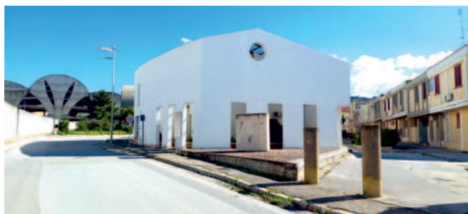
Fig. 2 Residenza Nicolin. Sulla destra una schiera di case costruite a totale carico dello Stato
