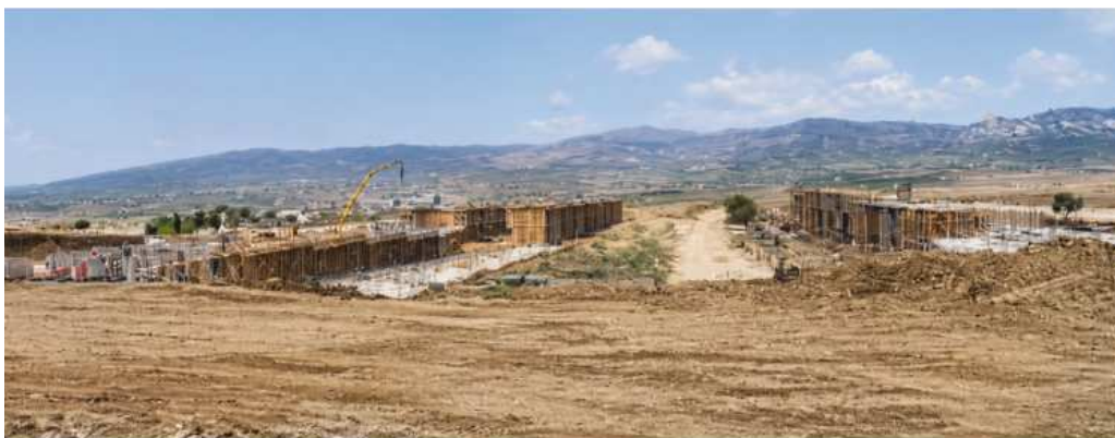
Fig. 13 Le case popolari in costruzione, immerse in un paesaggio ancora privo di urbanizzazione primaria e prossime alla strada statale
