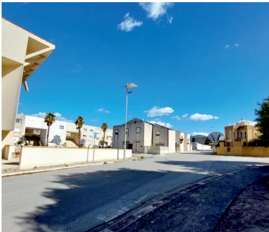
Fig. 43 Un'altra prospettiva dello spazio precedente. Da destra in senso antiorario: la casa del farmacista, il blocco Ungers e uno piccolissimo scorcio della casa Pirrello; al centro (nello slargo), due residenze dell'architetto Nicolín (foto, 2023)
